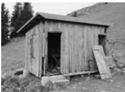
Untere Gonzenhütte vorher
