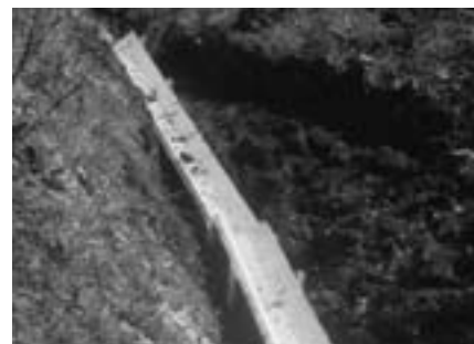
Rund 500 m V-Kännel konnten saniert werden
