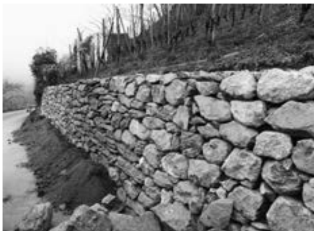
Die sanierte Trockenmauer hält nun wieder für viele Jahre.
