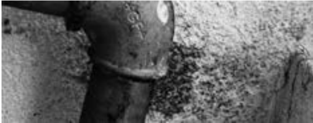
Defekte Wasserleitungen
