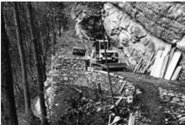
Bauarbeiten an der Stützmauer der Halbgalerie (Cornel Doswald 2016)
