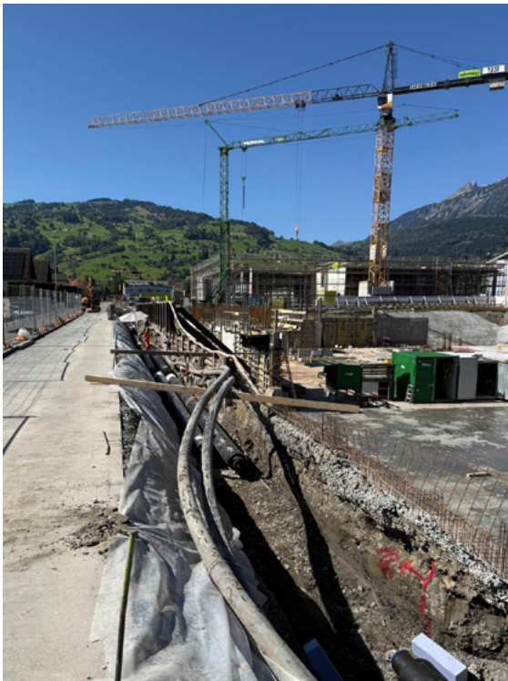
Umlegung Fernwärmeleitungen Oberer Wässertenweg
