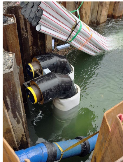
Einbau Düker mit Fernwärmeleitungen in Giessen 2024/2025
