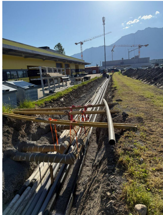
Umlegung Fernwärmeleitungen Oberer Wässertenweg
