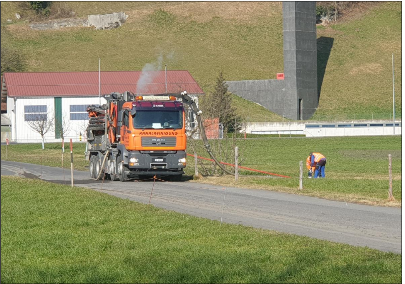
Reinigung der Verbandskanalisation.
