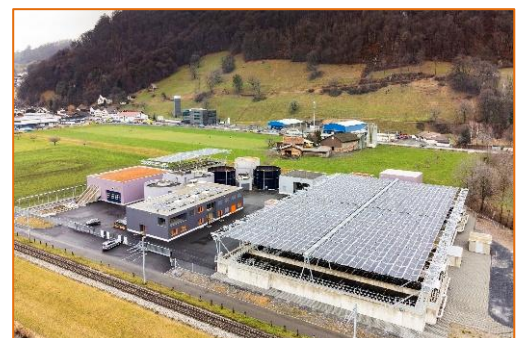
2023 ARA nach Ausbau
