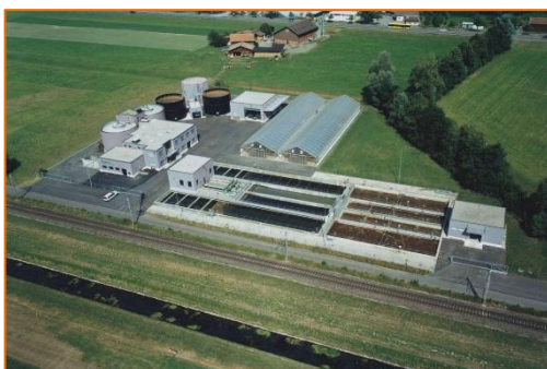
2019 ARA vor Ausbau
