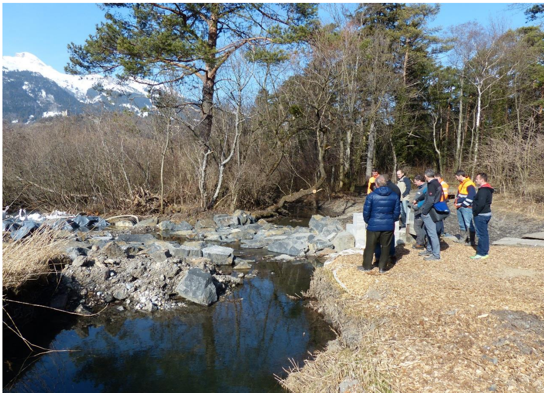
Aufwertung/Renaturierung Gewässerläufe Höwisen in Weite Baustellenbegehung bei Wasserentnahme am Mülbach
